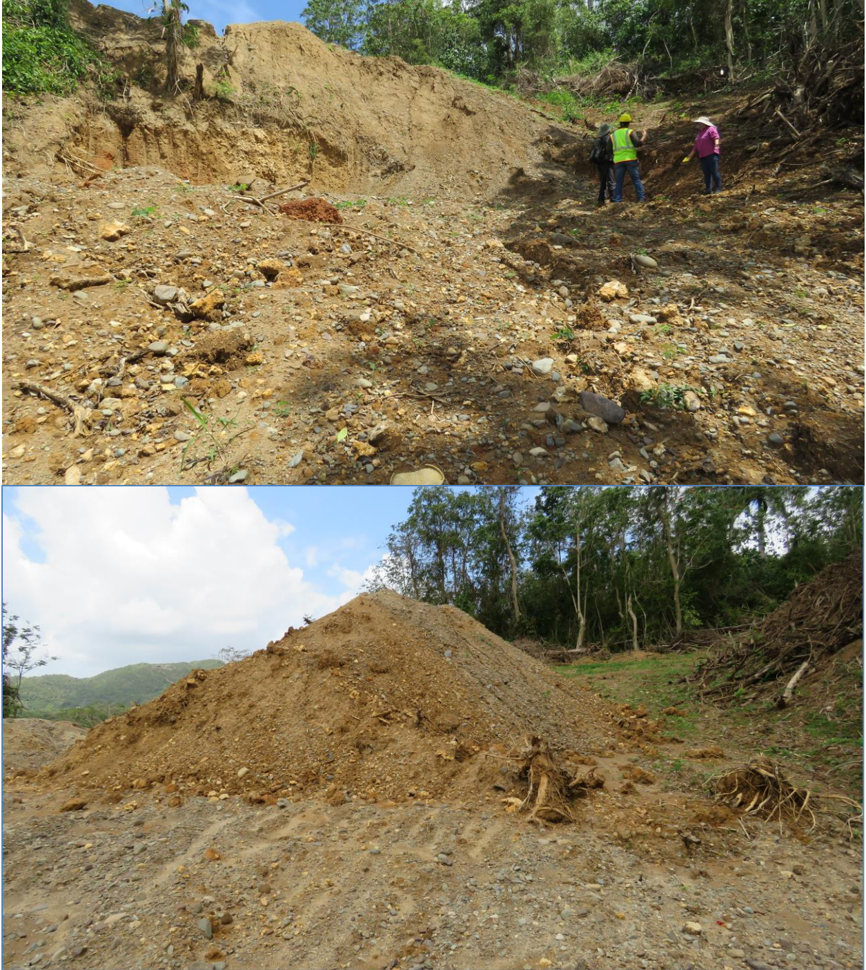
Imagen 2. Vista parcial del área donde se realizó la alegada estabilización del terreno y también se habilitó un camino. (Imagen inferior) Acumulación de material.
